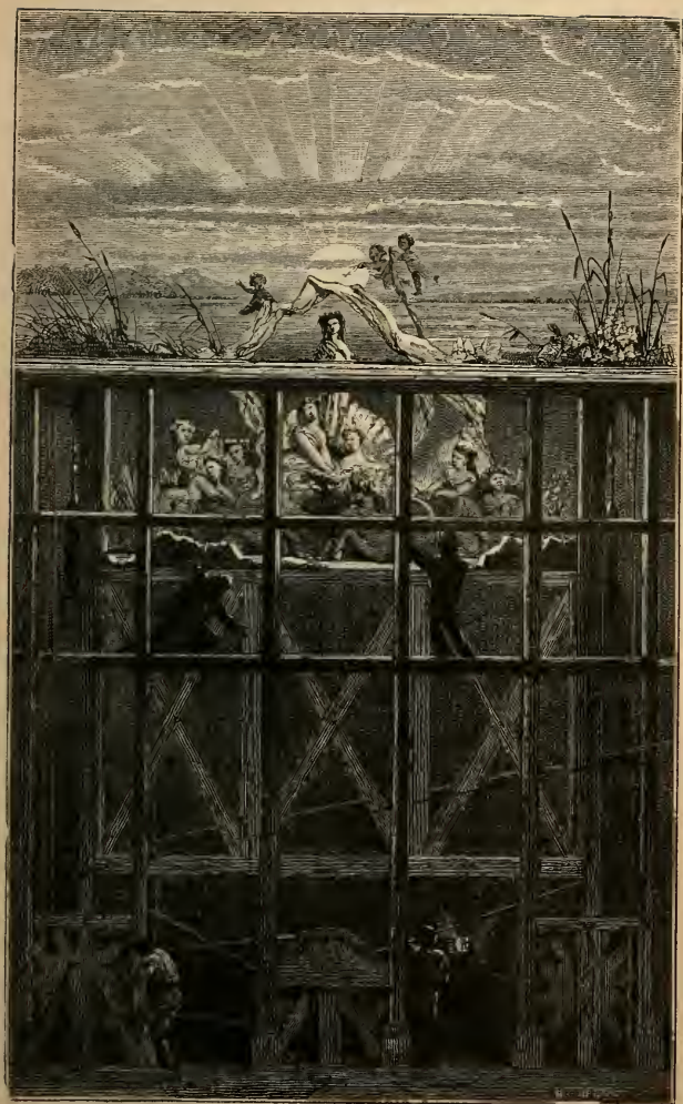
Fig. 41. — Bâti avec figures, équipé dans le dessous.
